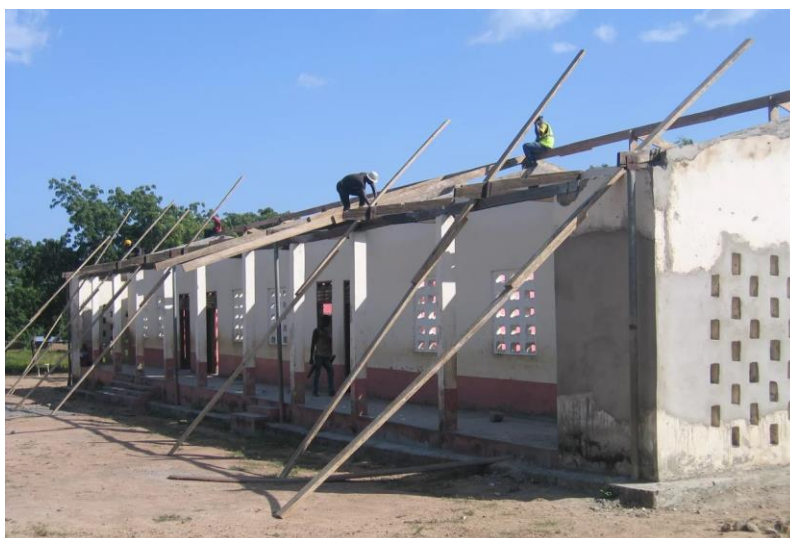
Opbouw en renovatie in volle gang.
