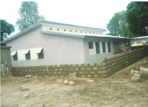
Renovatiwerkzaamheden aan de clicic en nurse house in Yikpabongo.
