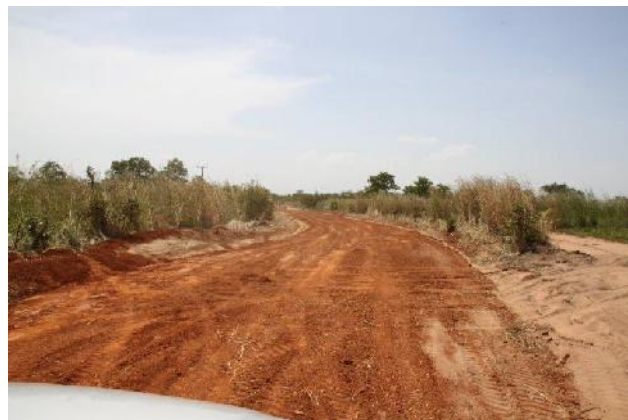
Aanleg weg voor ontsluiting van het gebied
